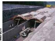
Beim Tunnelbau in offener Bauweise erfolgt die Herstellung des Tunnelbauwerks in einer offenen Baugrube, die anschließend wieder verfüllt wird. Die offene Bauweise wird überwiegend bei geringer Überdeckung verwendet.
