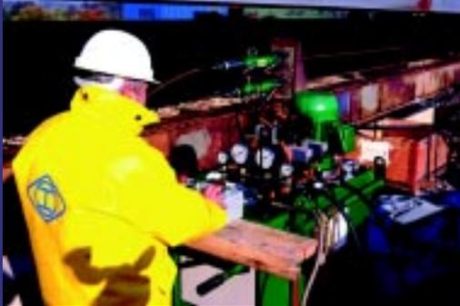
appuis de petit format pour la répartition de la charge sur une longueur de 2.0 en-dessous de l'âme. Le lancement est exécuté par deux vérins mono-torons, travaillant en phase, et tirant le chariot de lancement, qui glisse sur les rails par l'intermédiaire des patins en PTFE. Il n'y a pas de palées provisoires
