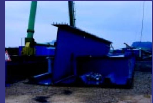
En section courante, les âmes sont munies de 2 séries de raidisseurs en forme d'augets trapézoïdaux d'épaisseur de 6 ou 10 mm. Sur appuis centraux, on augmente à 4 séries d'augets.
