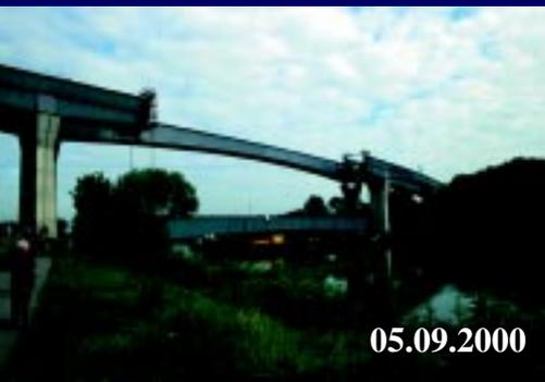
Provisoirement, pendant les phases de hissage et de bétonnage, la section du caisson en travée centrale a été fermée par un contreventement pour améliorer la reprise de la torsion due à la courbure en plan.
