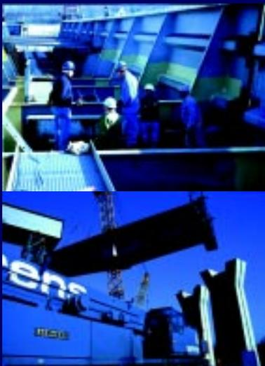
luxembourgeoise et caissons de rive à hauteur variable), lancement (caissons à hauteur +7- constante sur rive allemande) et hissage à partir d'un convoi fluvial sur la Moselle. Les parties hissées sont entièrement
