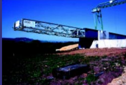
L'avant-bec est une structure droite en treillis d'une longueur de +/- 24 m, constitué de profilés laminés.
