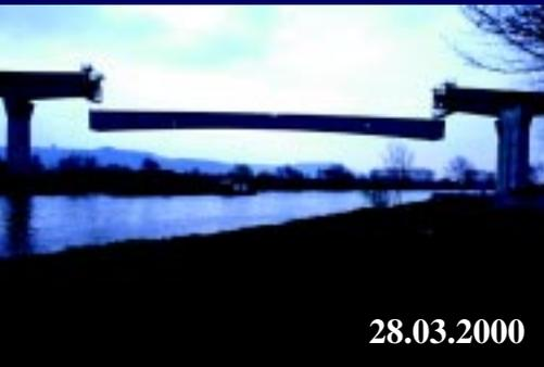
le réglage convenable des joints de soudure, un jeu de 75 mm a été laissé entre les caissons, et on a surélevé provisoirement les appuis 40 et 70, adjacents aux piles principales.
