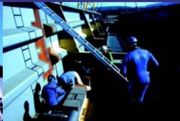
lançage, les éléments 19 à 25 ont été mis en place par grutage avec des grues automobiles, les éléments appuis centraux ont été levés
