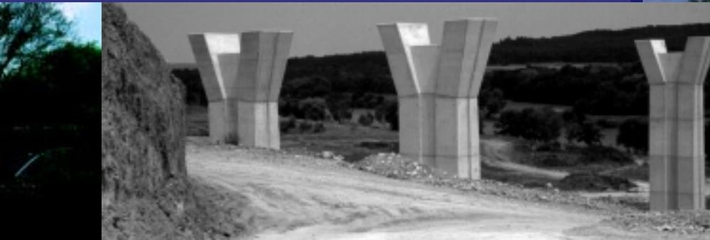
Pour l'exécution des piles, on a fait usage de paniers de ferrailage préfabriqués, mis en oeuvre par des grues tour. Les paliers intermédiaires des piles creuses sont constitués de prédalles.
