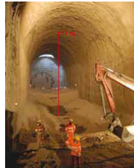
Kaverne mit Sohlgewölbe: im Hintergrund sieht man den Anschlag des Notstollens sowie den fertiggestellten Kaverneausbau.
