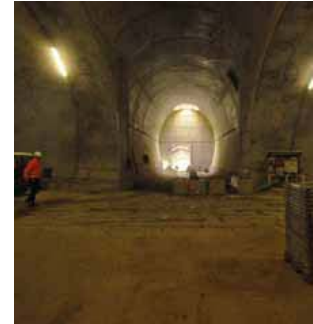
Innengewölbe der Kaverne
