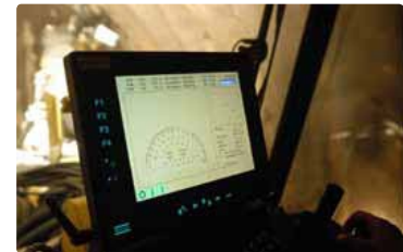
Hilfsautomatische Steuerung des Bohrwagens
