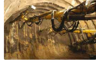
Bohren der Sprenglöcher mit 3-armigen Bohrwagen
