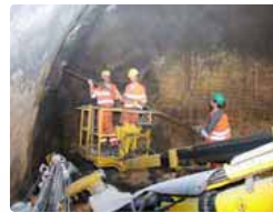
Manueller Einbau der Anker
