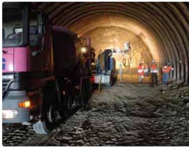
Spitzbeton: Betonmischfahrzeug und Spitzbetreiber
