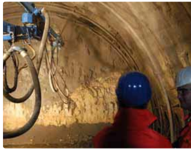
Spitzbeton: Feingesteuerter Spitzbetonbetriebe beim Einbringen eines Gitterträgers
