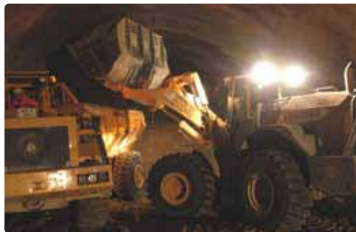
Schüttern: Beladen des Dumpers durch Radlader
