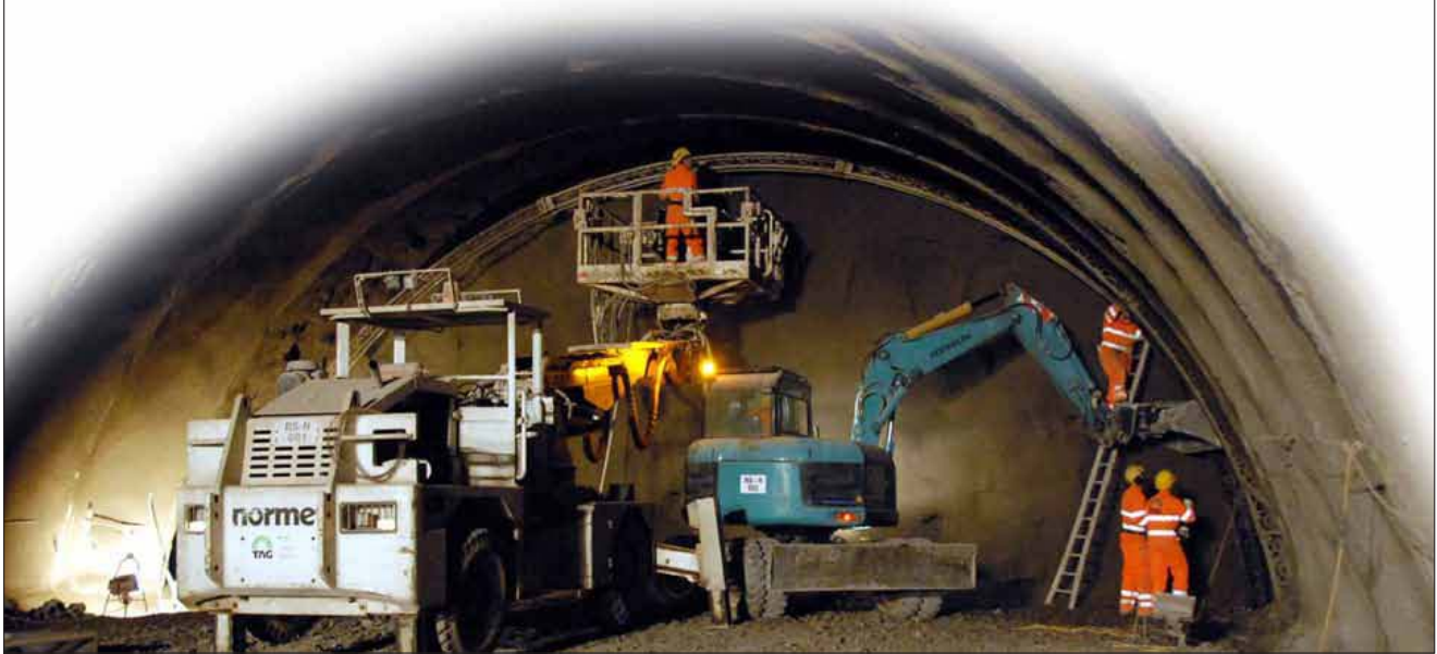
Manueller Einbau der Anker
