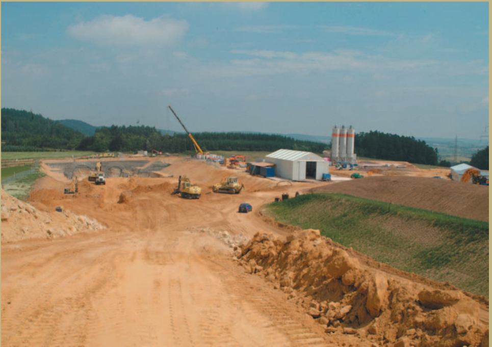
front d'attaque et installation de chantier sud
