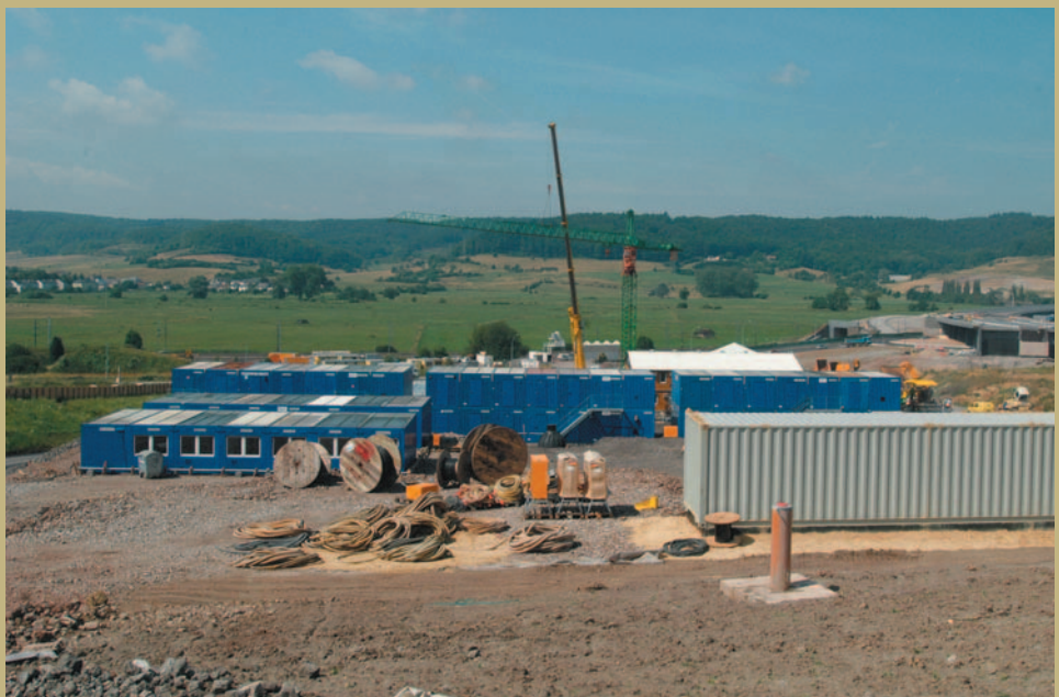
installation de chantier nord
