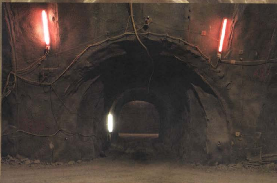
les galeries de secours / die querschläge
