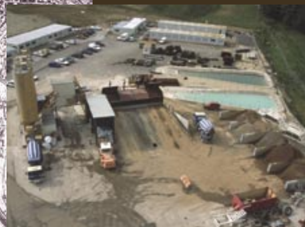
installation de chantier entrée nord
