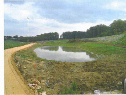
Bassin de rétention
