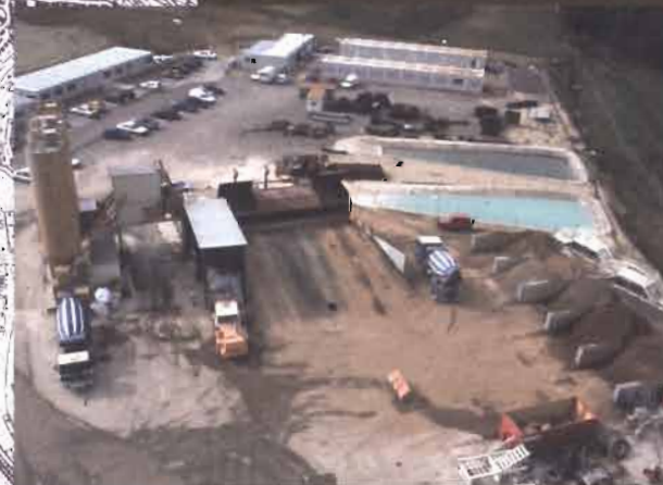
installation de chantier entrée nord
