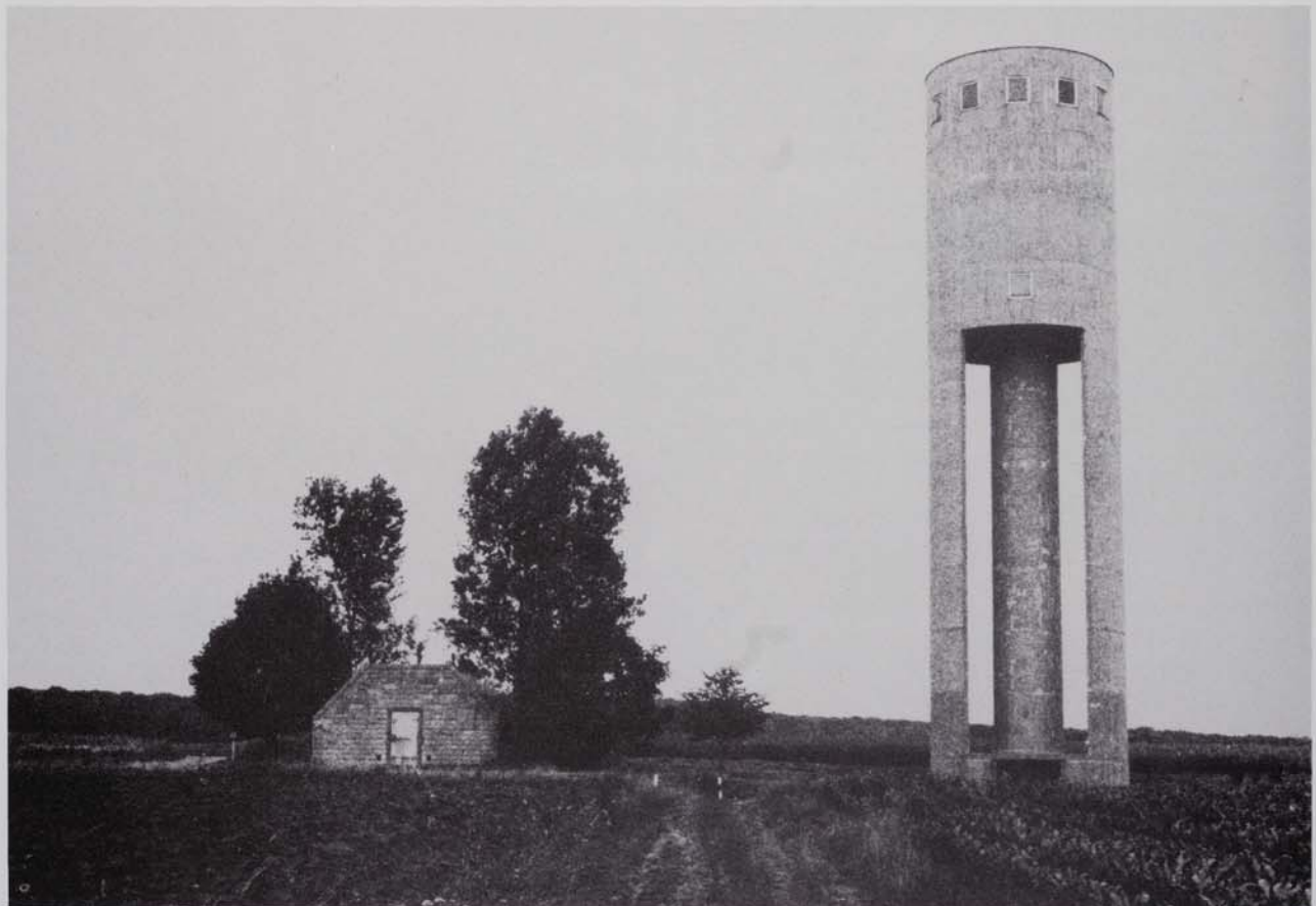
Réservoir d'eau à Ellange et Château d'eau à Elvange
