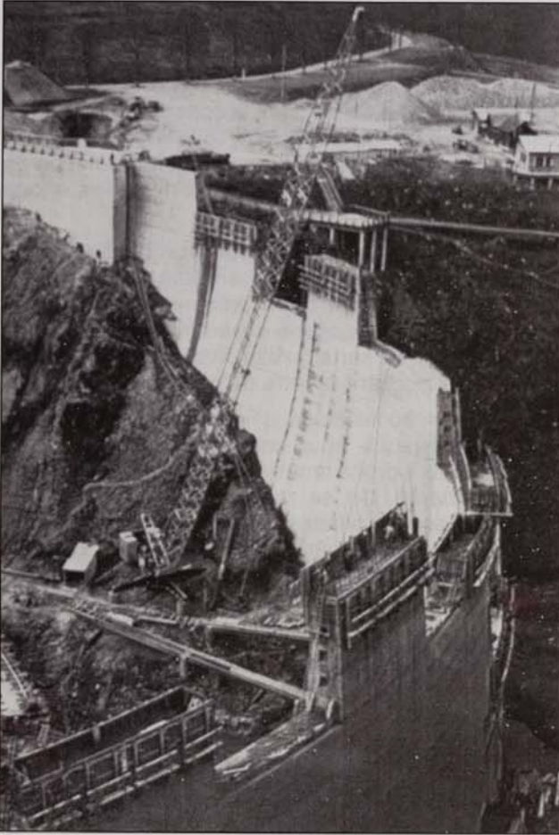
Photo 1: Bétonnage de la voûte.
