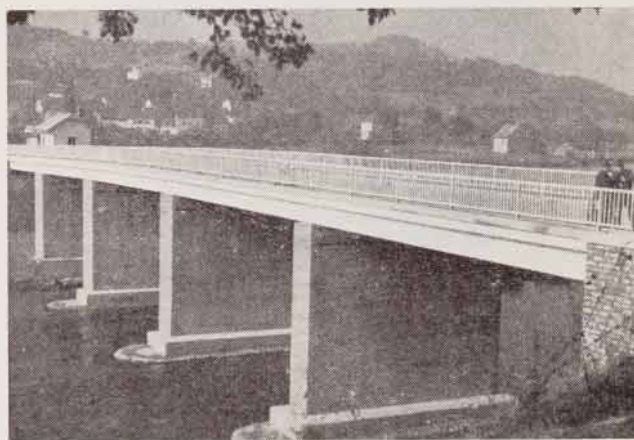
Fig. 13. — Pont sur la Sûre à Rosport.
