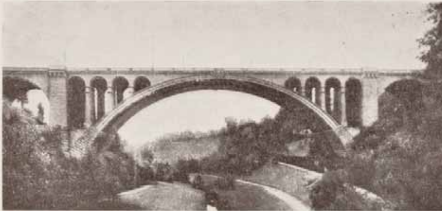
Fig. 2. — Pont Adolphe sur la Vallée de la Pétrusse à Luxembourg 1899—1903. Projet et direction des travaux: P. Séjourné.
