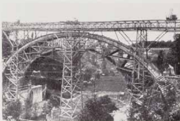
— Fig. 32 — La première voûte est terminée.
