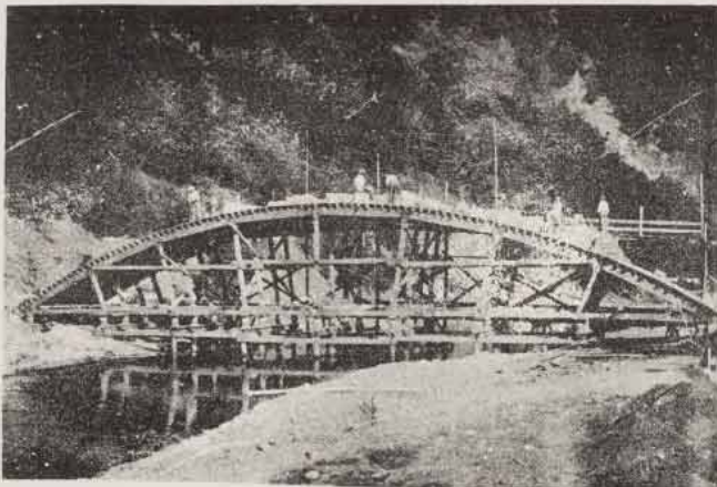
N° 7 — Construction du 1 er rouleau en six attaques.
