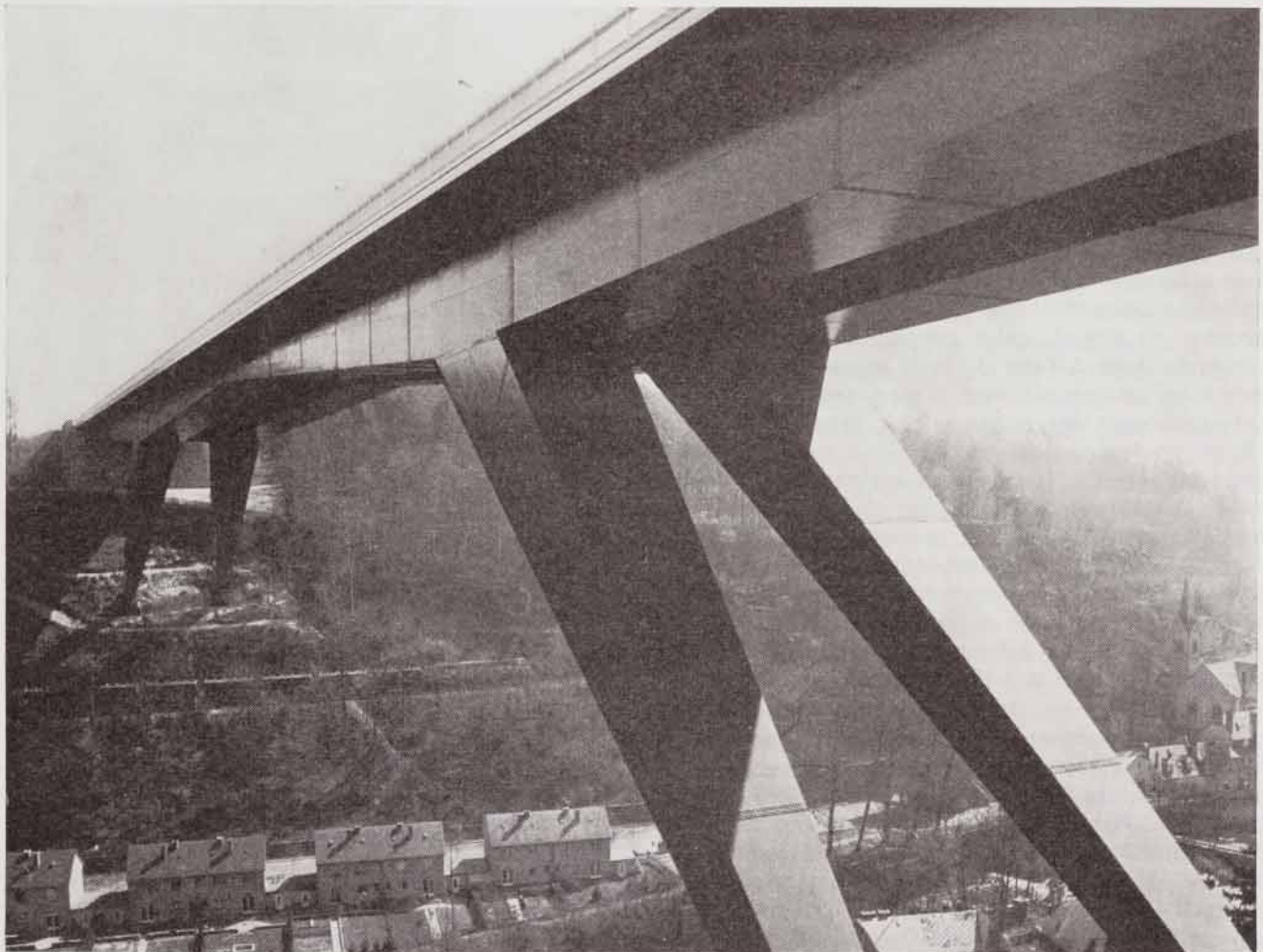
Fig. 15. Vue générale de l'ouvrage terminé
