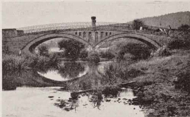
Ancien pont en maçonnerie. (Photo Kutter.)
