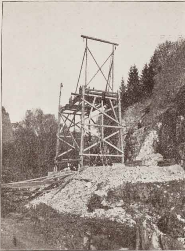
N° 14. — Montage des poteaux des étages supérieurs.
