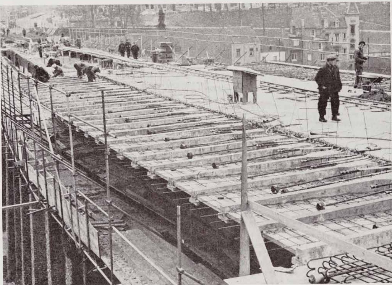
Fig. 7. — Elargissement en porte-à-faux.
