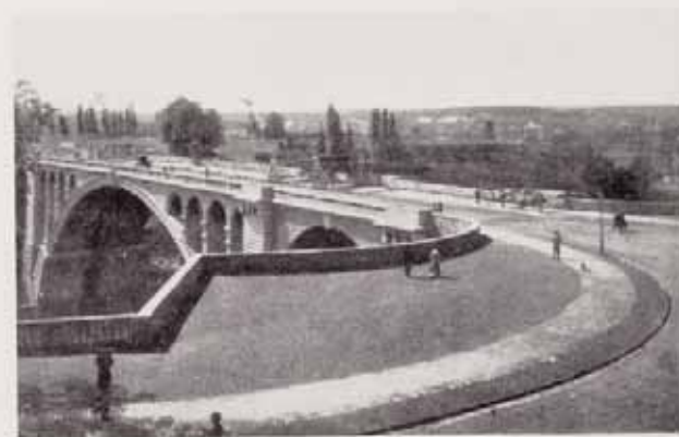
Fig. 44 — Le pont terminé vu du côté de la Ville.
