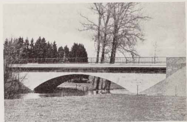
Fig. 6. — Pont sur l'Attert à Reichlange.
