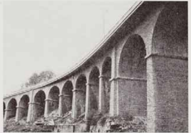
Fig. 11. — Vue partielle de l'ouvrage élargi.
