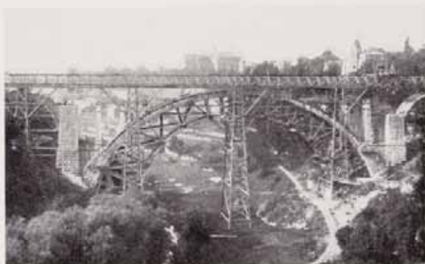
Fig. 33 — Travaux de maçonnerie aux pilastres et aux voûtes d'évidement.
