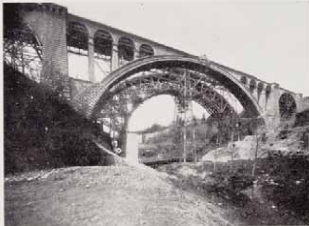
Fig. 38 — Le ripage du cintre est terminé.
