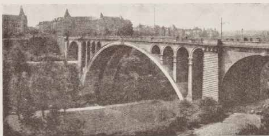
Fig. 1. — Pont Adolphe sur la Vallée de la Pétrusse à Luxembourg 1899—1903. Projet et direction des travaux: P. Séjourné. Entrepreneurs, Pont: MM. Fongeroles; Dalle en béton armé: M. Ed. Coignet.
