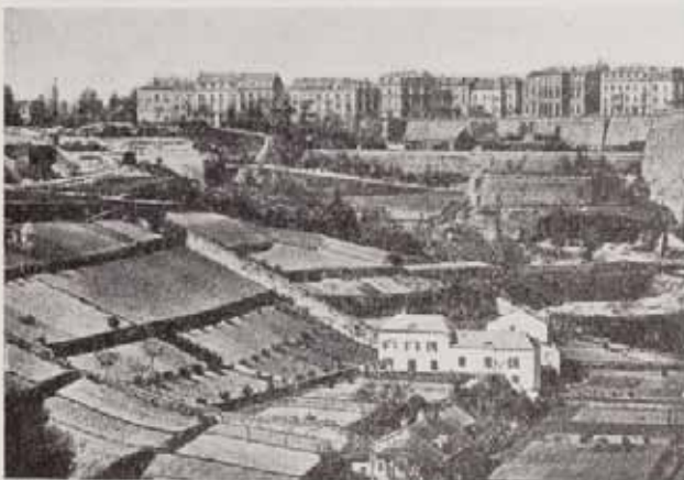
Fig. 3 — Vue prise du côté de l'ancien viaduc avant la construction du pont.
