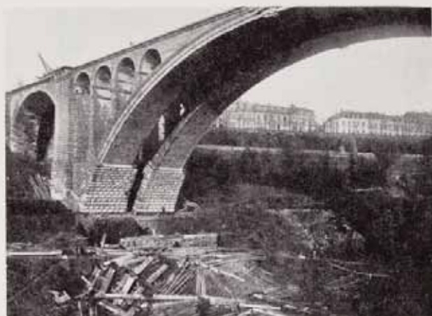
Fig. 42 — Le pont décintré.
