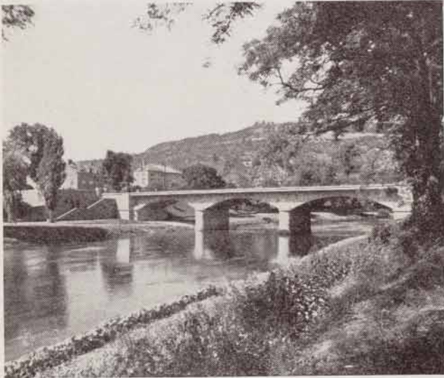
Fig. 1a. — Pont sur la Sûre à Diekirch.
