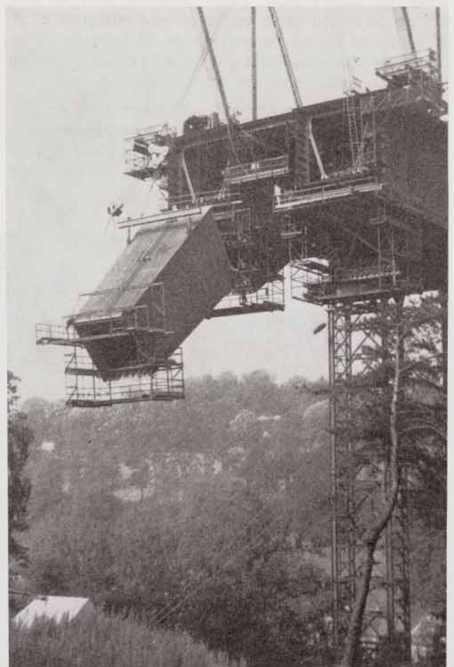
Fig. 10. Montage d'un caisson de béquille côté Kirchberg
