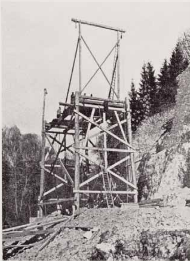
Fig. 26 — Montage d'un pylone du pont de service sur le versant du plateau Bourbon.
