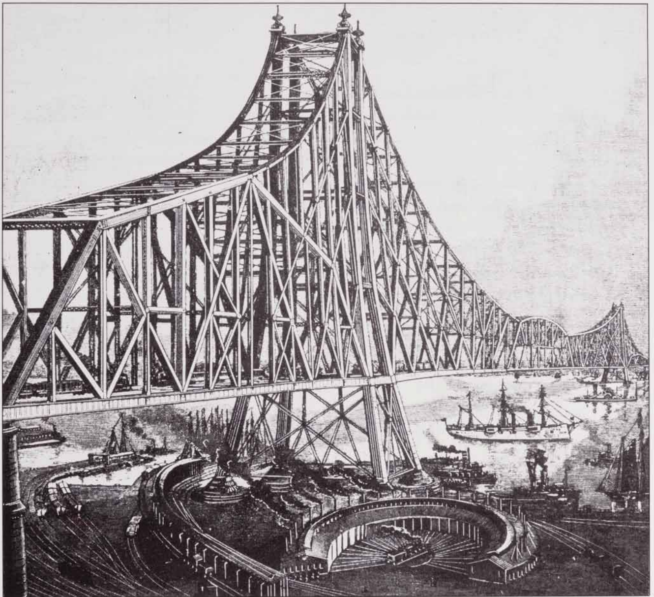
Fig. 7: Pont sur l'Hudson (1890). Portée 700 m.
