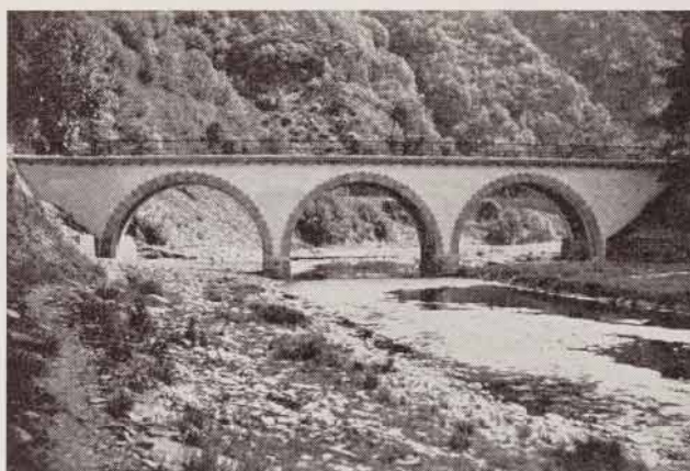
Pont sur la Sûre au moulin de Bourseheid.
