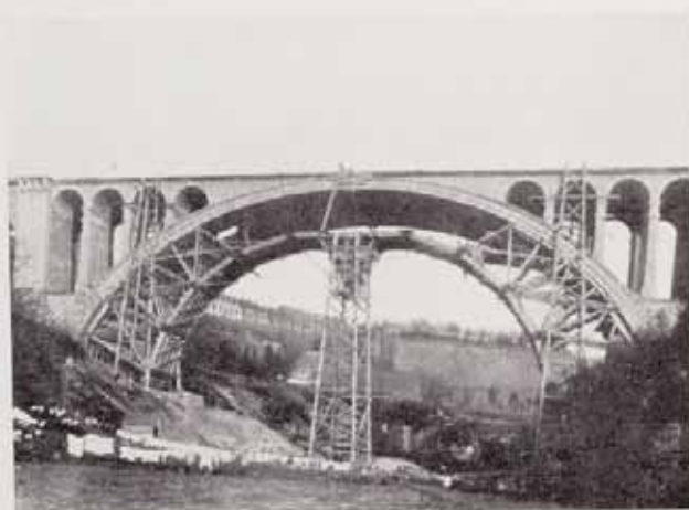
Fig. 41 — Démontage du cintre.
