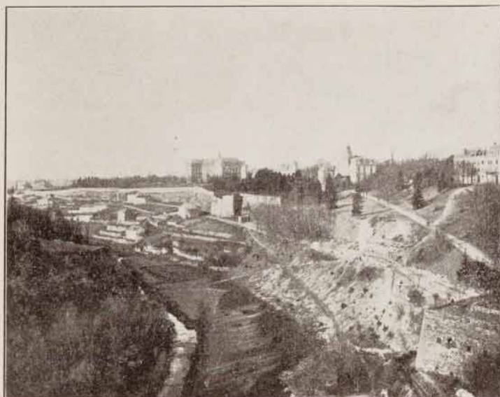
N° 12. — Fouilles pour les fondations de la grande voûte.
