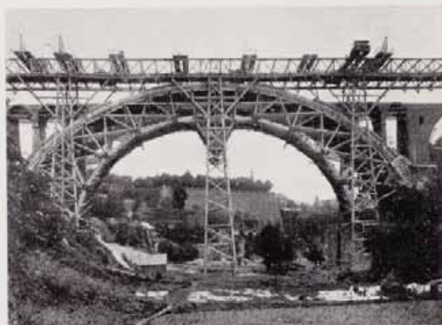
— Fig. 40 — La 2 e voûte peu avant son clavage.
