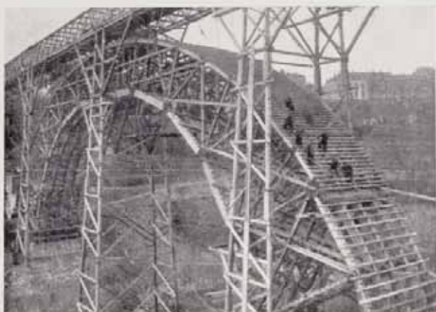
Fig. 29 — Le montage du cintre est terminé.
