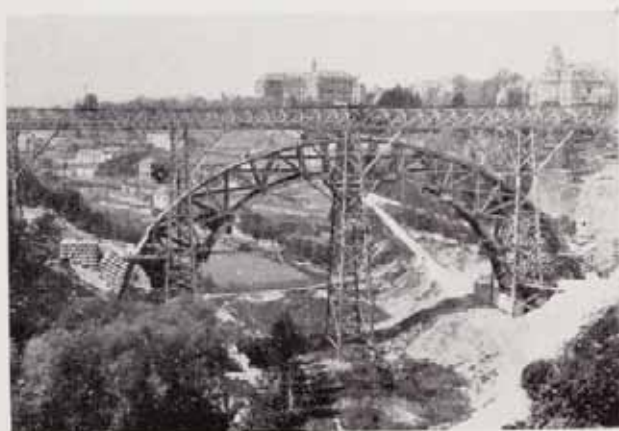
Fig. 31 — Les travaux de maçonnerie ont commencé aux retombées de la voûte.
