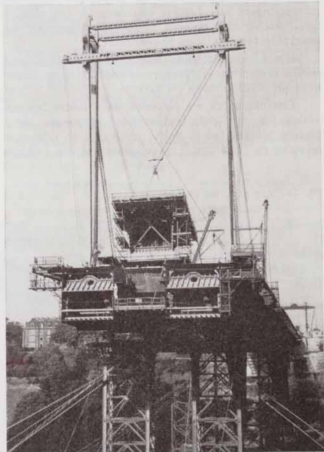
Fig. 14. Renforcement des caissons au droit des béquilles
