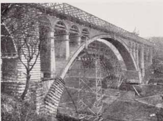
Fig. 36 — Ripage du cintre. La poutre américaine repose sur la première voûte.
