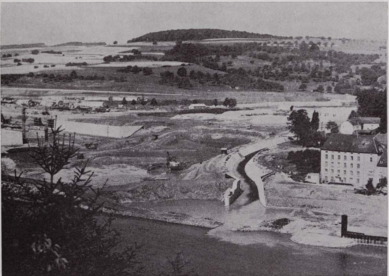
Les travaux à l'entrée du port
