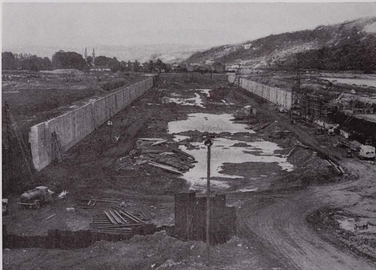
Situation des travaux d'aménagement du bassin en septembre 1965
