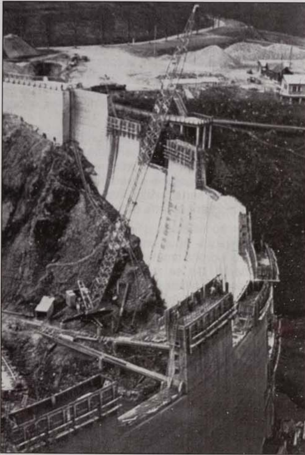
Photo 1: Bétonnage de la voûte.
