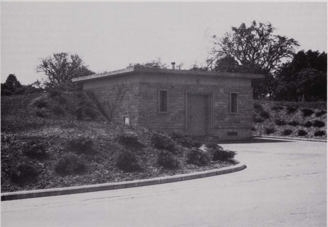
Réservoir d'eau à Berbourg
