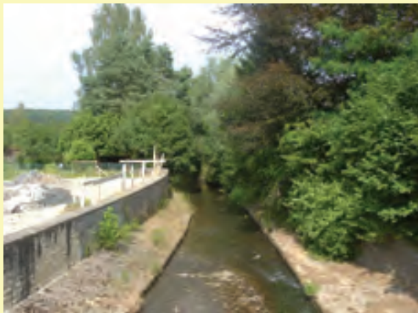
Situation initiale avant nouvelle construction et installation des pieux de fondation (après destruction de l'ancien bâtiment).
