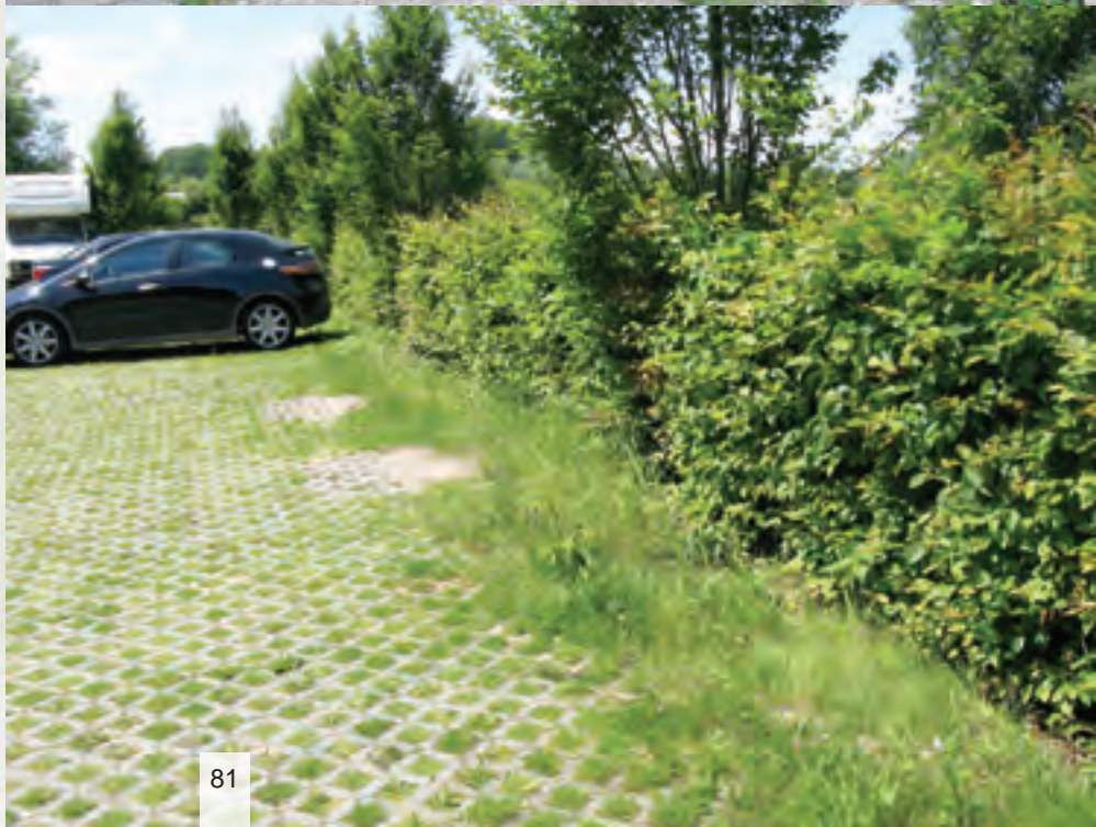
Les différents genres de substrats maigres : les pavés non posés dans le béton (en haut), le concassé (au milieu), et les systèmes alvéolaires (en bas).
