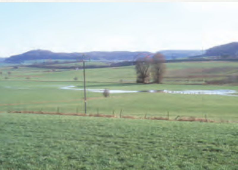
Dégradation du cours d'eau au niveau de son tracé : le cours d'eau a été déplacé en dehors du thalweg naturel. Le tracé originel réapparaît lors des pluies.
