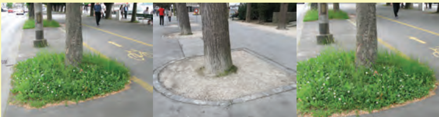
Exemples positifs: Plates-bandes individuelles avec arbres, réalisées en concassé, dans un trottoir recouvert d'enrobé noir, à Lucerne (Suisse).
