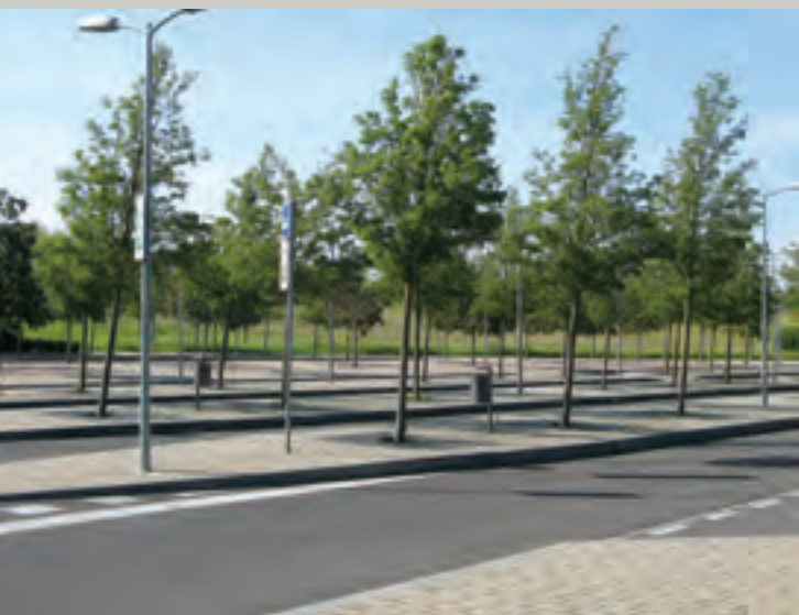
Exemple négatif: Réalisées entièrement en pavés, les surfaces de circulation ne peuvent pas se couvrir d'une végétation herbacée naturelle en raison de l'épandage d'herbicides.
