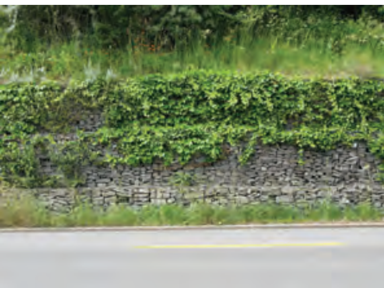
Mur en gabions à Lucerne (Suisse).
