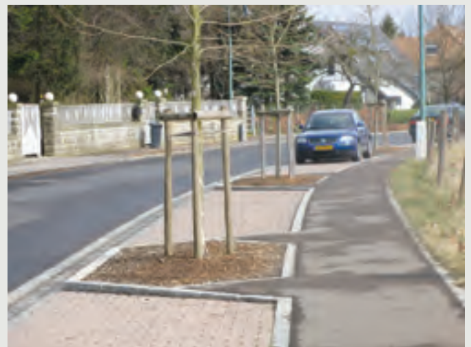
Exemple négatif: Critiques: couleurs non adaptées au paysage, plates-bandes délimitées par des bordures, remplies de terre arable et couvertes de copeaux d'écorce. Les arbres auraient dû être plantés dans le substrat maigre de la bande de stationnement.
