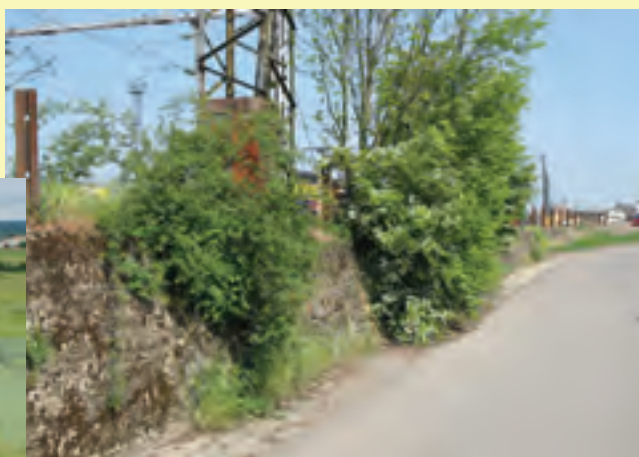
Mur à Bettembourg
