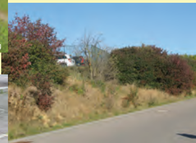
Talus dans la zone d'activité à Strassen
