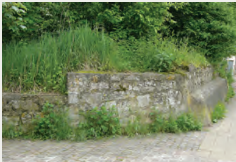
Exemple positif: Mur le long d'un trottoir à Bettembourg avec à son pied une bande herbacée naturelle qui a pu s'installer spontanément comme suite à la renonciation aux herbicides par l'Administration communale.
