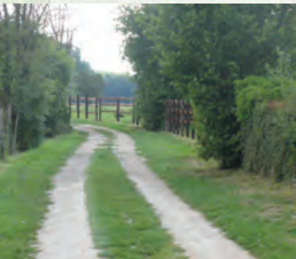
Exemple positif: Chemin rural à Busancy (France), réalisé en concassé et couvert de végétation herbacée qui s'est installée spontanément.
