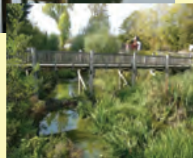
Pont piétonnier à Pétange.
