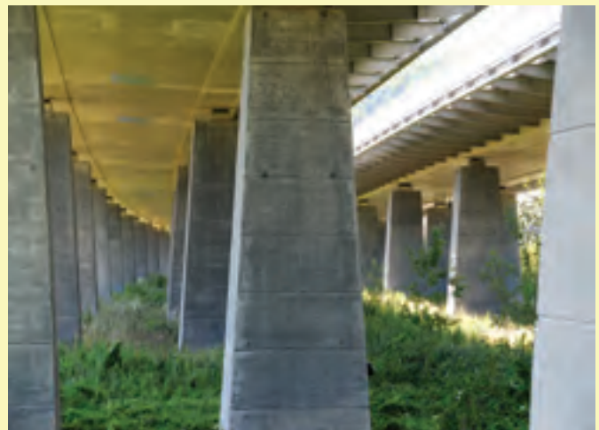
Le viaduc de Lorentzweiler est disposé sur des piliers sur toute la largeur de la plaine alluviale de l'Alzette. Les eaux peuvent ainsi librement s'étendre en largeur, même après renaturation du cours d'eau.
