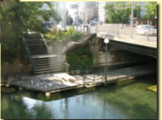
Chemin sur pilotis en milieu urbain à Zürich (Suisse). Il se situe à une vingtaine de centimètres au dessus du niveau de l'eau du cours d'eau. En période de crue il n'est pas accessible. Il a été renoncé à l'installation d'un garde-corps.
