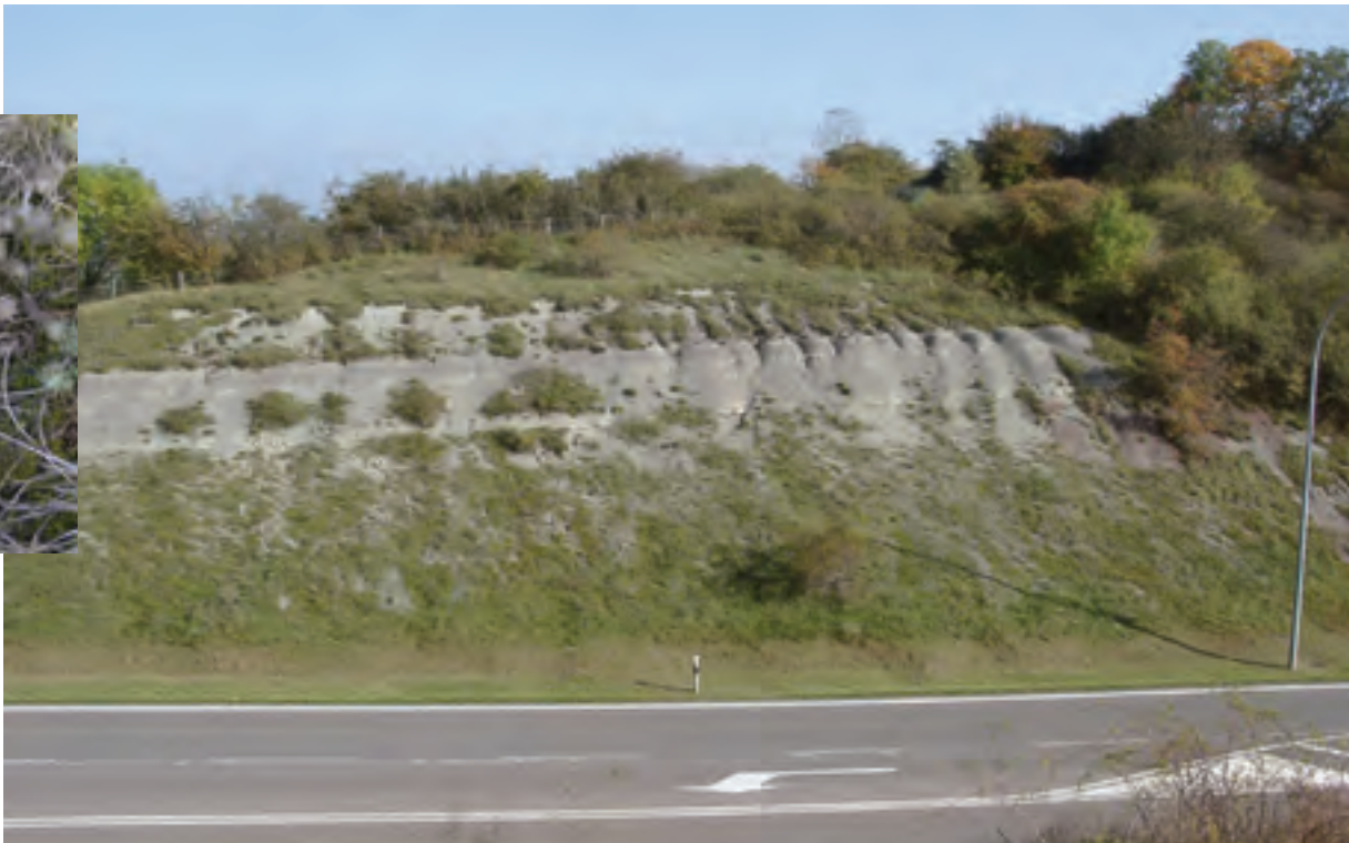
Exemple positif: Talus le long de la route N11 de Luxembourg à Echternach au niveau de Graulinster. Il a été renoncé au recouvrement avec de la terre arable, de sorte que le substrat géologique affleure. Il permet le développement de plantes adaptées aux conditions stationnelles du site. En octobre 2010, s’y trouvaient 39 espèces de plantes, dont 7 caractéristiques des habitats secs et des pelouses calcaires sèches, comme la Scabieuse colombarie ( Scabiosa columbaria ), le Boucage saxifrage ( Pimpinella saxifraga ) ou l’Euphorbe Petit-Cyprès ( Euphorbia cyparissias ), de même qu’une espèce typique des habitats rocheux (l’Orpin de Forster, Sedum forsterianum , ci-dessus).
