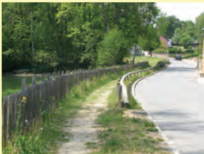
Trottoir derrière glissière à Beckerich.
