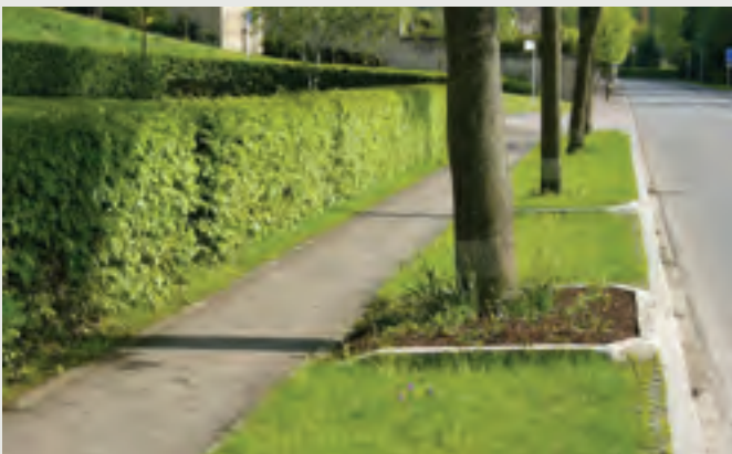
Exemple négatif: La bande de stationnement étant réalisée en dalles alvéolaires, il aurait été avantageux de renoncer à l'aménagement de plates-bandes avec arbres, délimitées avec des bordures, remplies de terre arable et couvertes de copeaux d'écorce. Les arbres auraient dû être plantés directement dans les dalles alvéolaires.
