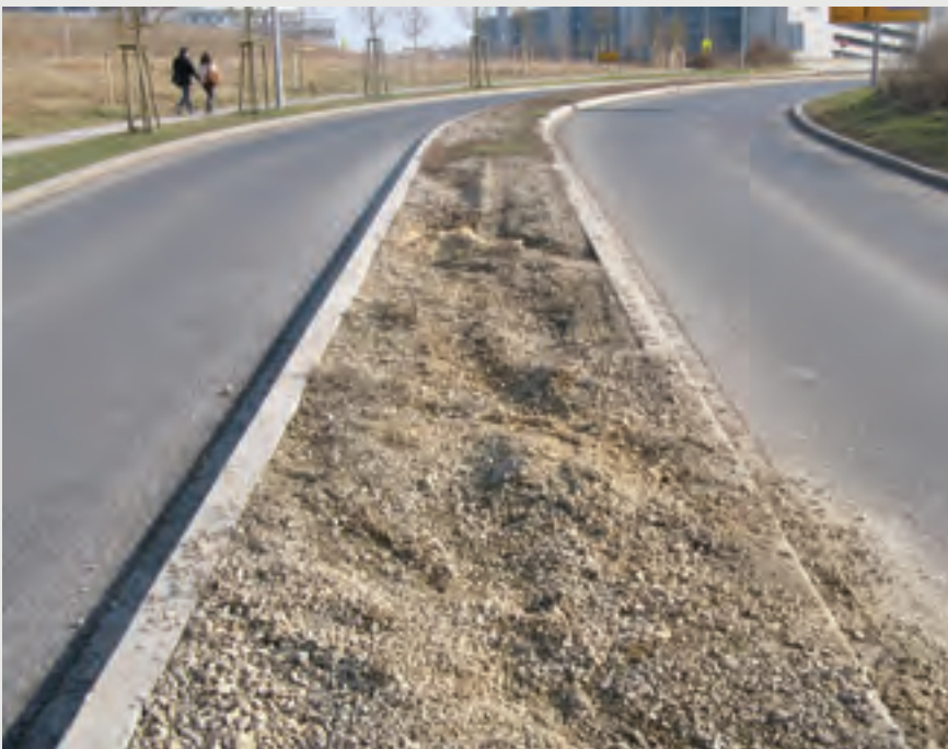
Exemple négatif: Ilot en gravier. Un calibrage non approprié (sans particules fines) conduit à la formation d'ornières.
