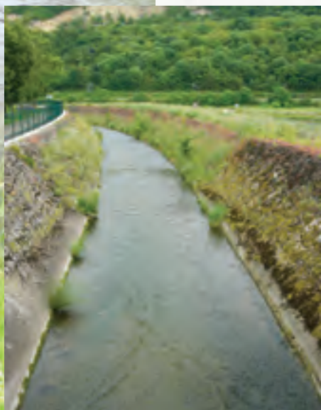
Mauvais état morphologique de la Syre à Mertert : le lit n'est pas seulement réduit en largeur et entaillé en profondeur, mais son fond et ses berges sont en plus consolidé par des ouvrages construits.
