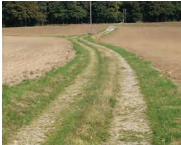
Chemin rural en concassé rudimentaire (structure monocouche).
