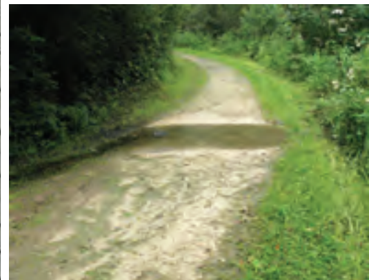
Exemple positif: Chemin mixte pour piétons et cyclistes en concassé à Pétange. L'eau passe par-dessus la surface de circulation par un gué. Dans ce genre de projets, il importe de veiller à la sécurité des usagers (signalisation).
