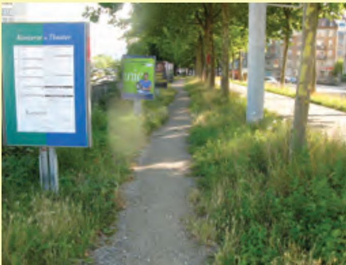
Trottoir en concassé à Zürich (Suisse).
