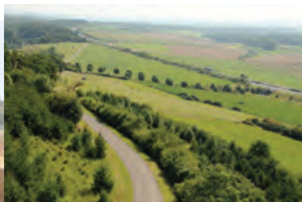
Exemple positif: Autoroute A1 au niveau de Flaxweiler. Implantation du tracé dans le respect du relief naturel.
