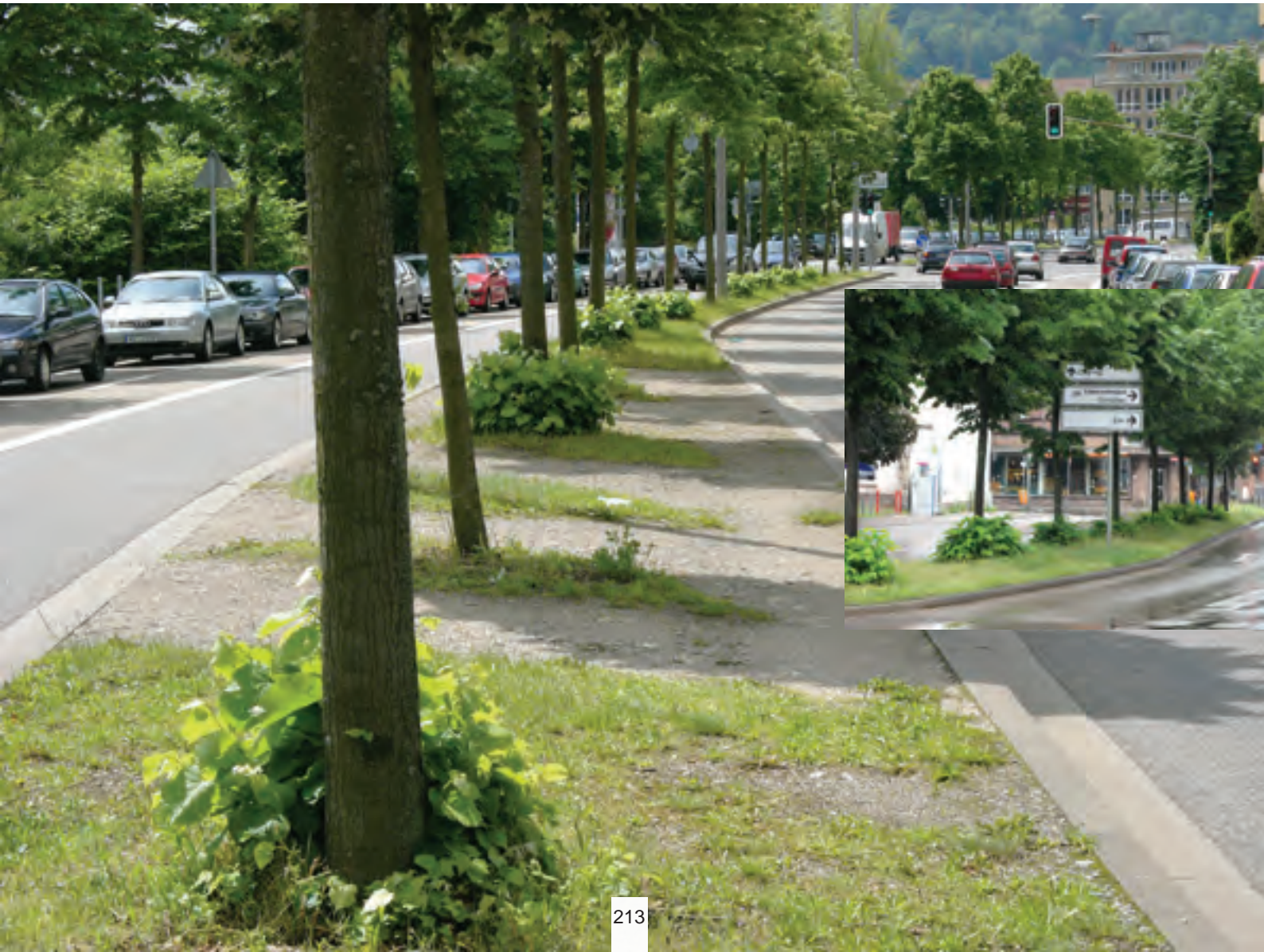
Exemples positifs: Ilots en concassé à Saarbrück (Allemagne), avec arbres et végétation herbacée qui a pu s'installer par succession naturelle.
