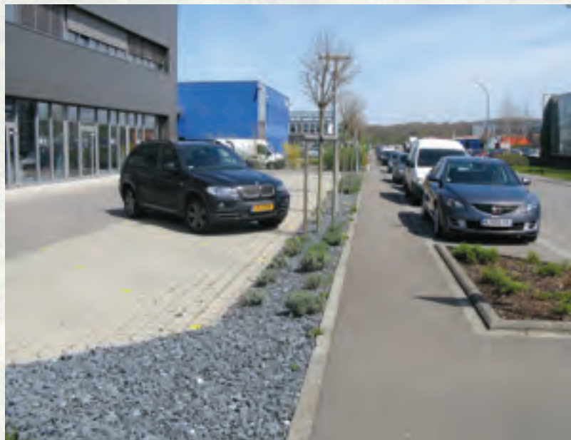
Exemple négatif: La bande de stationnement entre la chaussée et le trottoir, la plate-bande, l'espace vert sur le terrain privé ainsi que le parking privé auraient pu être aménagés dans un seul et même substrat maigre.
