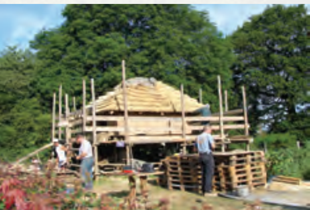
Exemple positif: La construction des abris pourrait faire l'objet d'une exécution artisanale et manuelle par les équipes d'organisations sociales.
