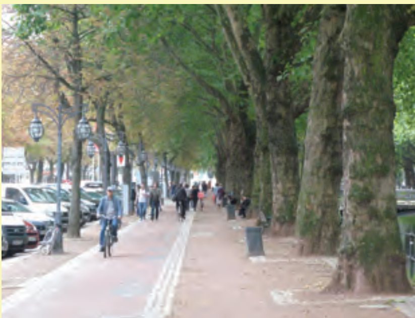
Trottoir en concassé le long de la Königsallee à Düsseldorf (Allemagne).
