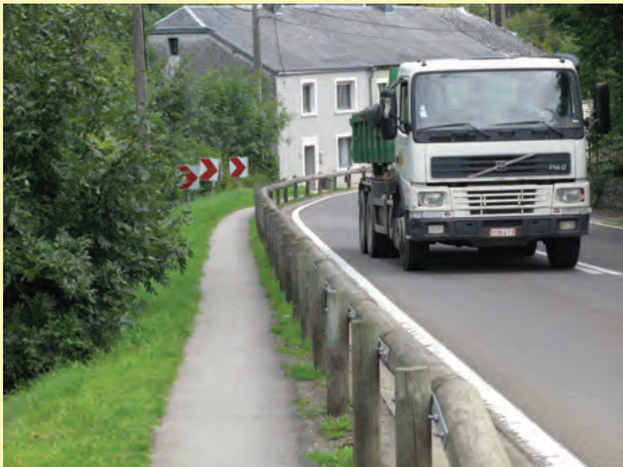
Trottoir en asphalte derrière glissière en Belgique. La glissière est posé dans le concassé (et non dans la terre organique)
