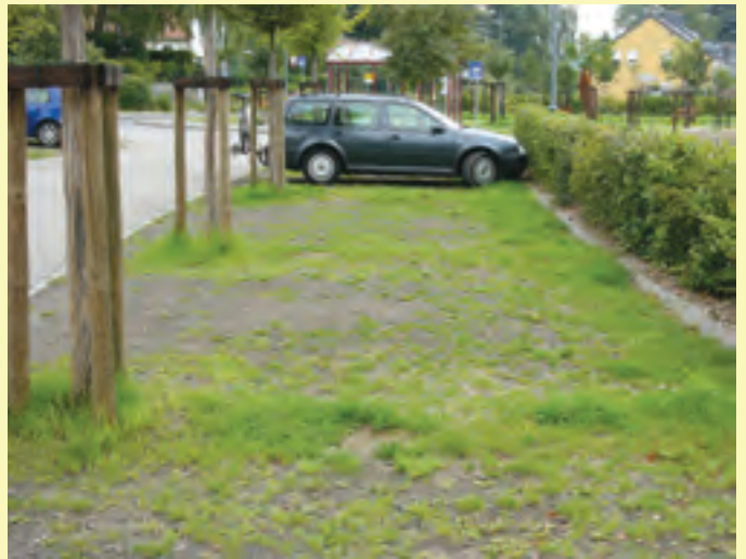
Parking écologique à Beaufort. Les arbres et la haie déterminent l'ordre interne du parking. La végétation herbacée naturelle peut s'installer aux endroits où les véhicules ne circulent pas (le long de la haie, dans la ligne de projection des arbres). Il existe des transitions fluides entre les surfaces de circulation et les surfaces végétalisées. La bordure le long de la haie et la couche de copeaux d'écorce au pied de la haie sont superflus.
