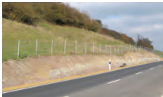
Après le redressement ou l'élargissement d'une route, il faudrait renoncer au recouvrement en terre arable des talus, en vue de favoriser les stations à substrats maigres qui sont devenues rares dans les paysages modernes.
