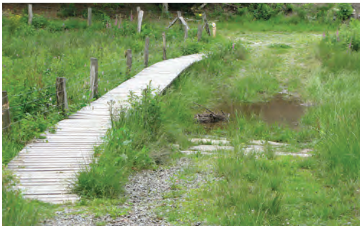
Exemple positif: Chemin sur pilotis (pour piétons) et gué (pour véhicules) dans la zone protégée «Conzefenn» à Weiswampach. La traversée des cours d'eau et de leur plaine alluviale par un chemin ou une route peut être aménagée de façon à limiter voire exclure des dommages à la nature.
