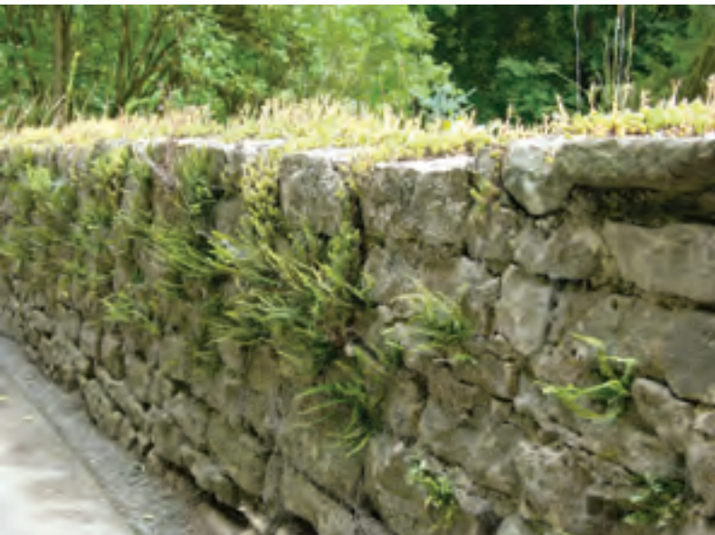
Mur en maçonnerie sèche à Manternach.
