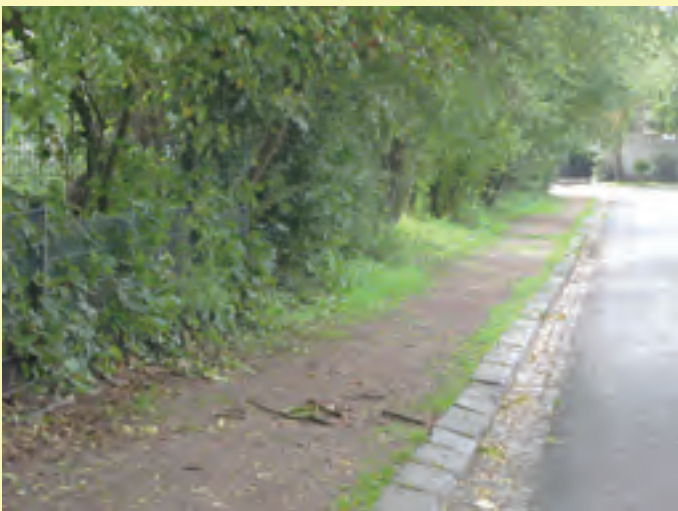
Trottoir en concassé à Herne (Allemagne).
