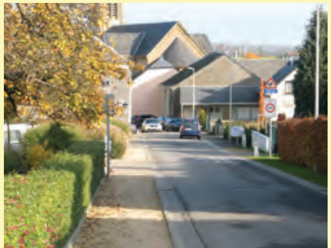
Trottoir en concassé à Arlon (Belgique).
