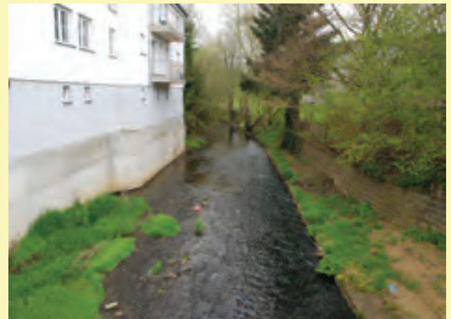
Augmentation de la capacité hydraulique et développement de la végétation aquatique suite à l'élargissement du cours d'eau par enlèvement du mur de soutènement.
