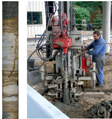
Machine de forage en opération
