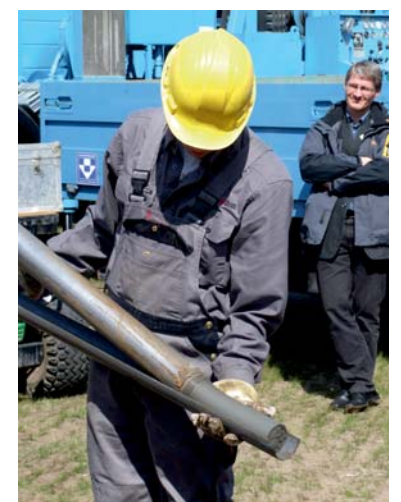
Extraction d'une carotte du carottier
