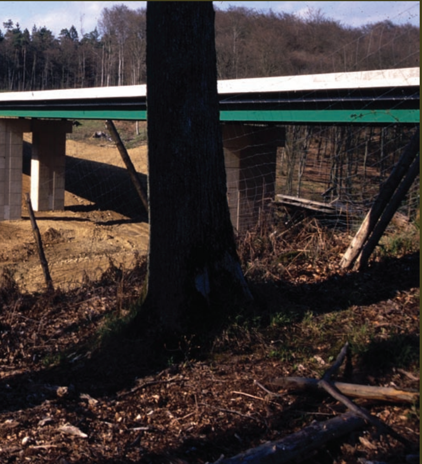
viaduc glaasbuurgronn viaduc groussheck
