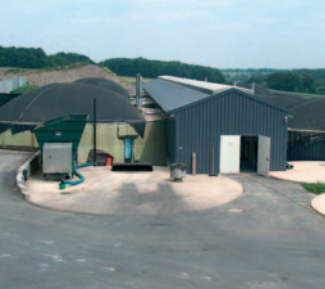
Le biogaz à Redange
