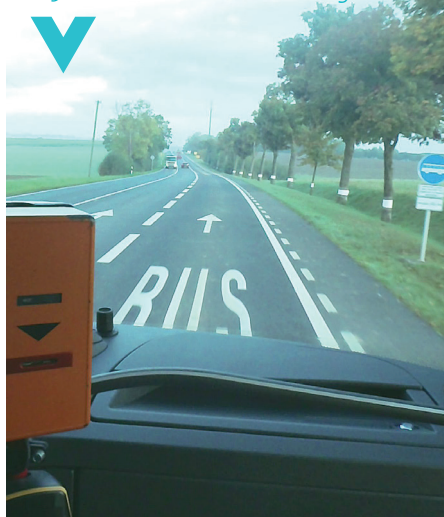
Un couloir pour bus intercommunal N3 entre Schlammesté et Alzingen
