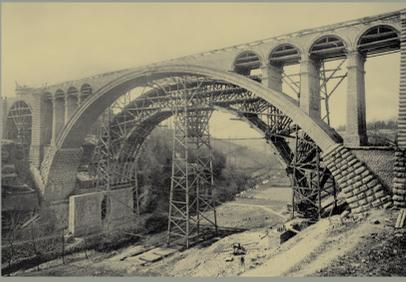
Zum Zeitpunkt der Inbetriebnahme am 24. Juli 1903 war die Adolphe-Brücke die größte Bogenbrücke der Welt: mit einer Gesamtlänge von 153 m über das Tal der Pétrusse und einer Rekord-Spannweite von 85 m.
