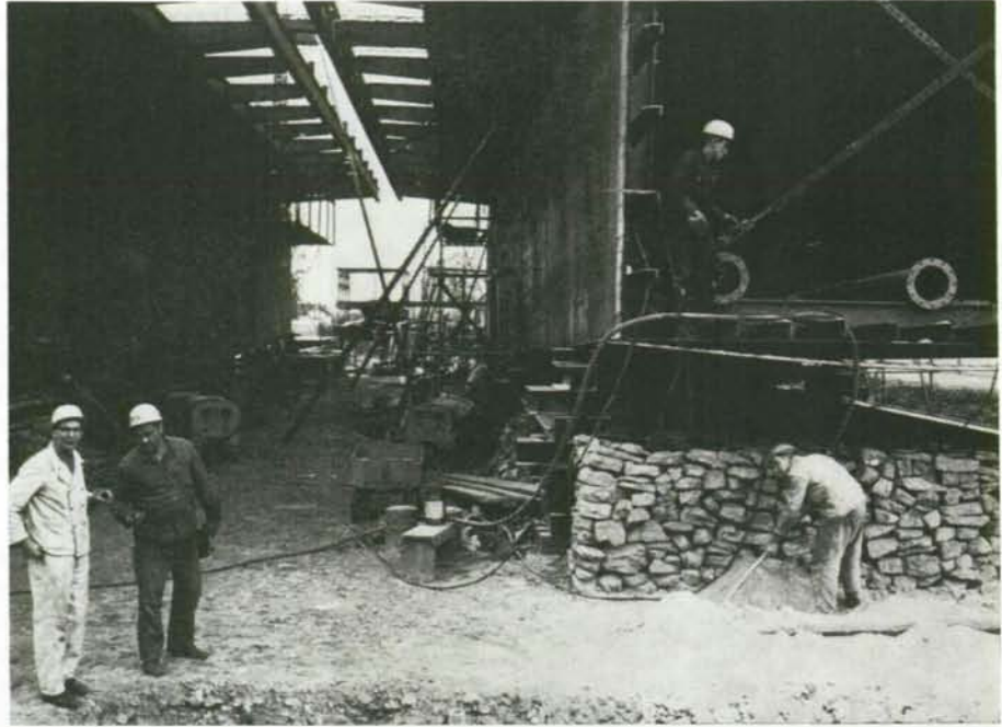
Fig. 7. Ajustage des caissons au chantier
