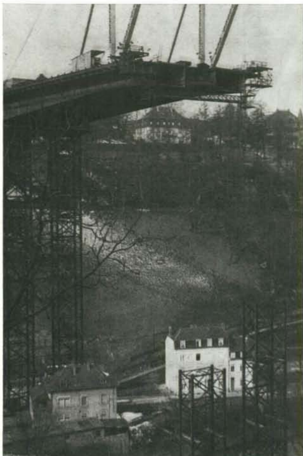
Fig. 9. Phase de montage au-dessus de la vallée de l'Alzette
