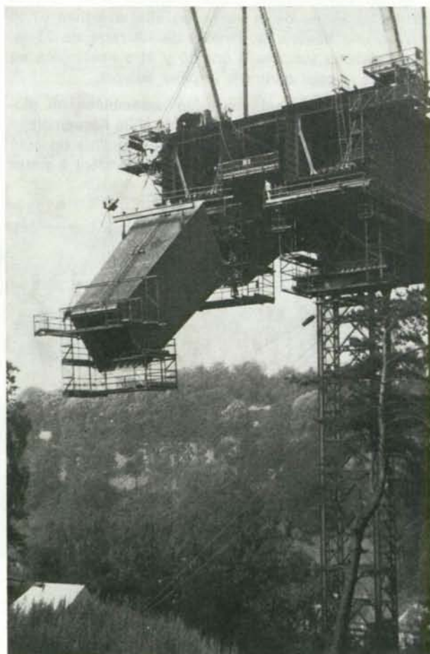
Fig. 10. Montage d'un caisson de béquille côté Kirchberg
