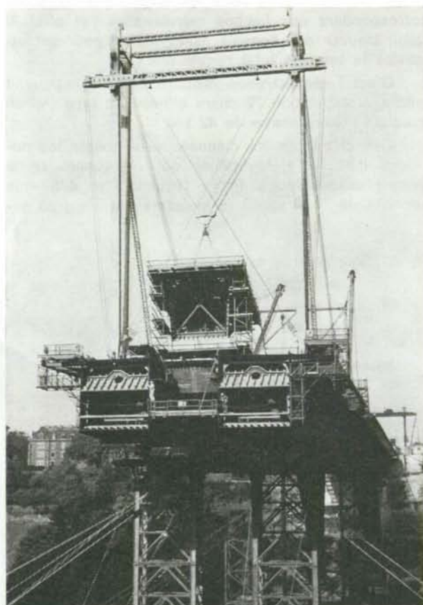
Fig. 14. Renforcement des caissons au droit des béquilles
