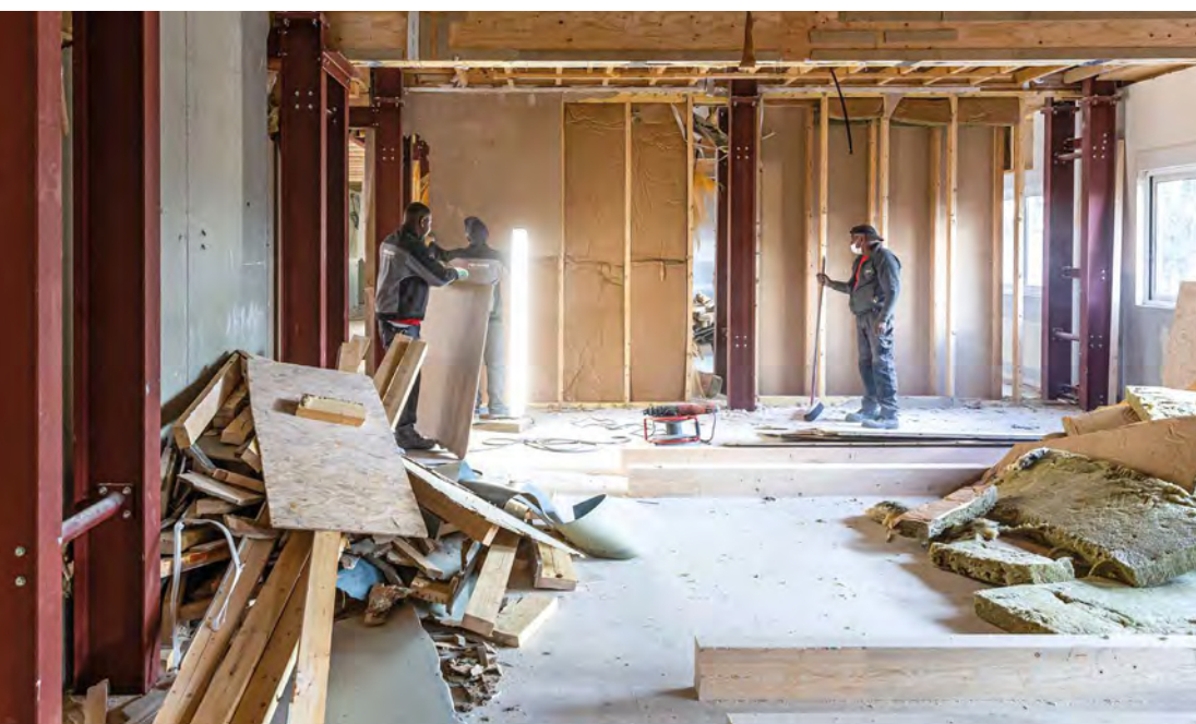
Démolition des murs en bois une fois que les deux parties du cadre sont en place et reliées.
