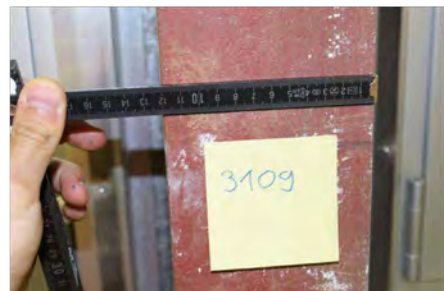
Bild 36: Fassadenstütze (HEA 120) in der Achse 14 im Raum 3109, Nr. 35
