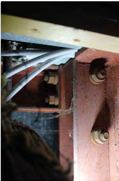
Bild 37: Blick auf den Anschluss in der Achse D-14, Fassadenstütze HEA 120, Unterzug IPE 300 sowie dem U-Profil U100, Nr. 36
