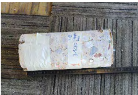
Bild 3: Kernbohrung aus dem Treppenhaus zwischen der Achse B-C/2-3, Nr. 1
