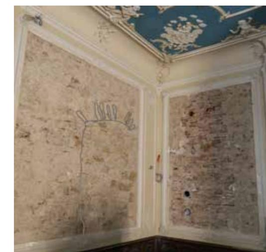
^ Fenêtre murée et orifices des tuyaux de poêles encastés dans un mur en briques
