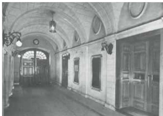
Les plans de l'architecte Sosthène Weis montrent la rénovation du passage d'entrée par un nouveau dallage suivant un calepinage déterminé, un traitement des voûtes avec joints pour suggérer un appareillage en pierre de taille, une mise en place de panneaux sur les murs latéraux (signalétique et miroirs) et un nouvel éclairage. Cette intervention a sans doute rendu le lieu un peu plus lumineux, accueillant et noble.
