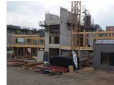
< Montage des Holzbaus
