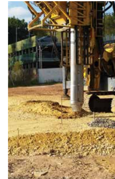
> Ausführung der Rüttelstopfsäulen
