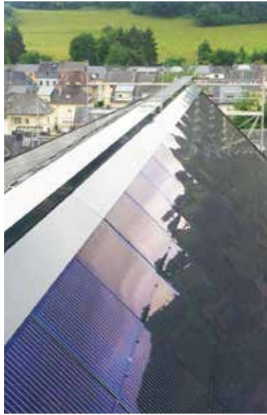
^ Ventilation en crête intégrée dans la passerelle d'entretien < Panneaux solaires intégrés faisant office de toiture
