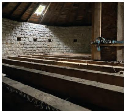
Enlèvement des pierres de moellons au-dessus de la coupole permettant le passage de la technique au 1<sup>er</sup> étage et le renforcement de la dalle par une poutre métallique pour poser l'escalier hélicoïdale.
