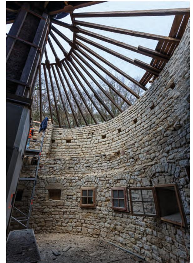
Une nouvelle structure métallique en construction légère s'encastre sous la charpente en dégageant et en mettant en valeur les anciens murs de fortresse.
