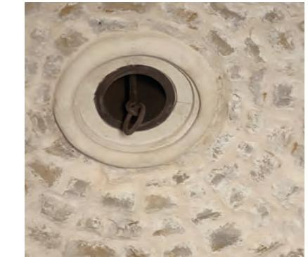
Eiserner Ring zur Befestigung eines Flaschenzugs im Scheitelpunkt der Kuppel des Erdgeschosses
