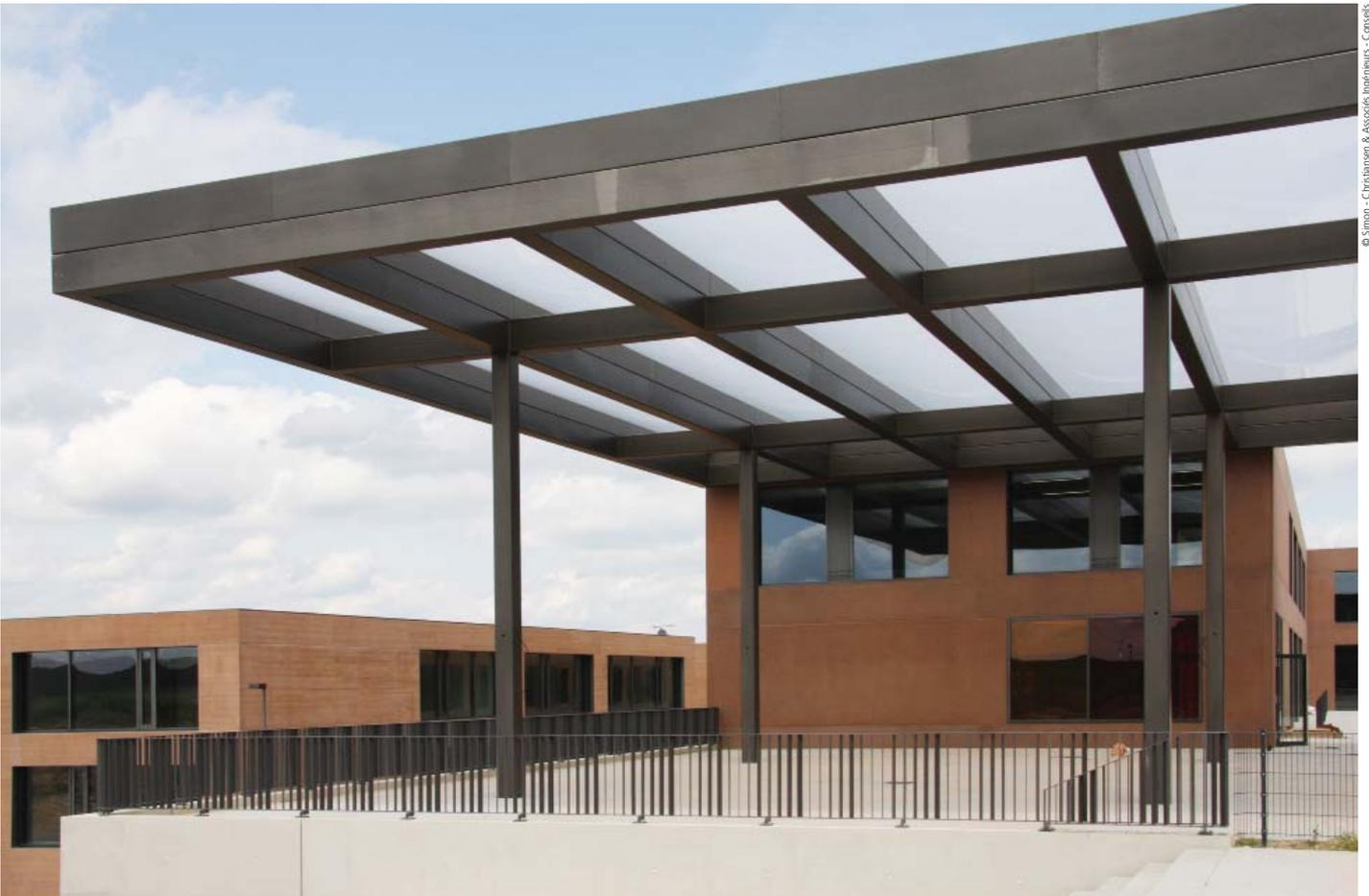
Das Dach der Sporthalle ist eine Holzkonstruktion bestehend aus weit gespannten Brettschichtholzbindern (BSH-Bindern) und einer Hohlkastendecke, die neben den Verkehrslasten aus Wind und Schnee die Lasten des Gründachs und des Betonplattenbelages aufnimmt. Der Artikel wird auf die Statik sowie auf die Lösungen verschiedener technischer Details eingehen.
