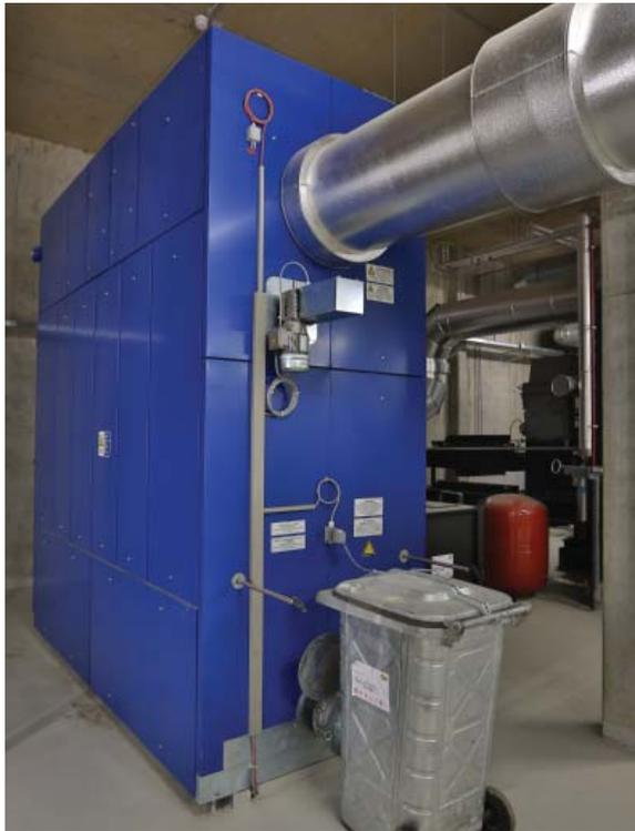
\_3 Elektrofilter zur Abgasstaubung
