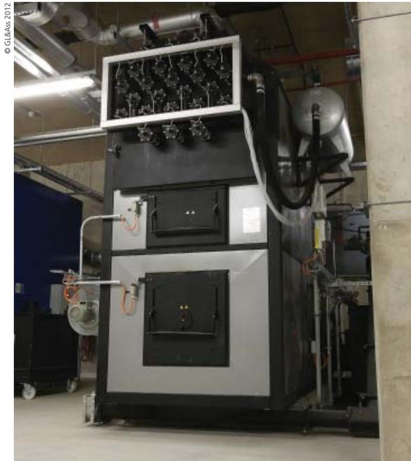
\_1 Hackschnitzelkessel mit pneumatischer Abreinigung der Kesselzüge
