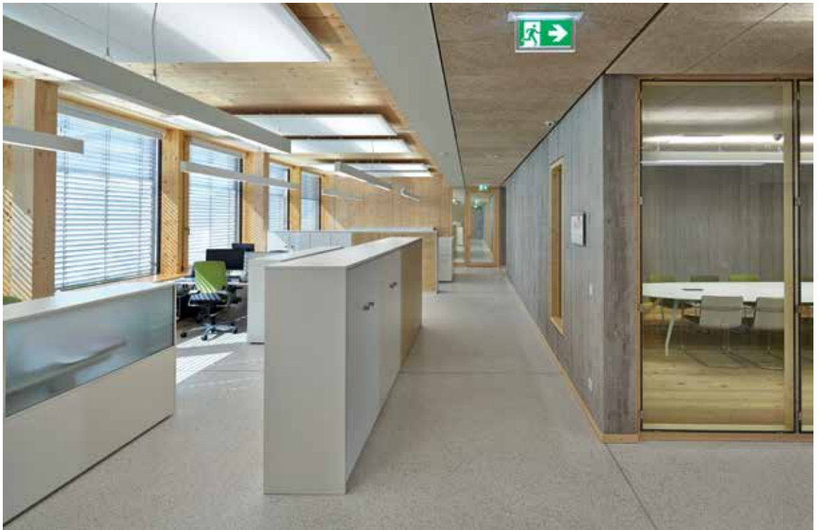
Ablesbares Material- und Konstruktionsprinzip am Beispiel der offenen Südbüros; Holzelementdecken- und Stützen, Betonkern mit Sichtbrettschalung und geschliffener Zementestrich
