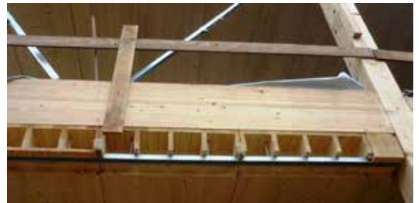
_Hochhängung der Holzdecken im Bereich der fassadenseitigen Randträgern
