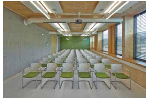
_Lüftungsauslässe im Konferenzraum
