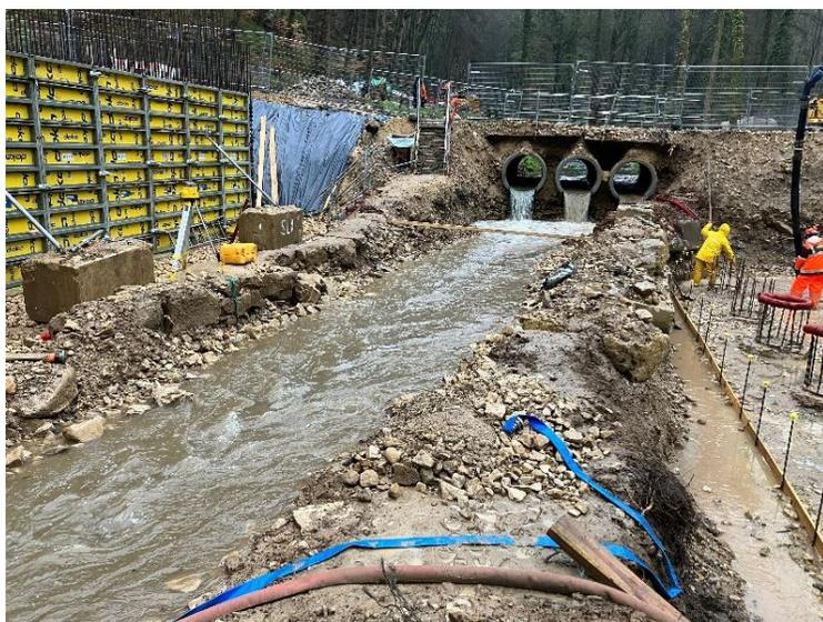
La reconstruction des 2 ouvrages comprenait le coffrage des culées, la mise en place du ferrailage, le bétonnage, la mise en place de la voûte préfabriquée de l'OA359 et la confection du tablier de l'OA355. La mise en place des étanchéités et de l'asphalte, la construction des trottoirs sur les ouvrages et de la dalle pour le passage souterrain et enfin l'habillement de l'ouvrage avec des pierres d'Ernzen complètent ces travaux.
