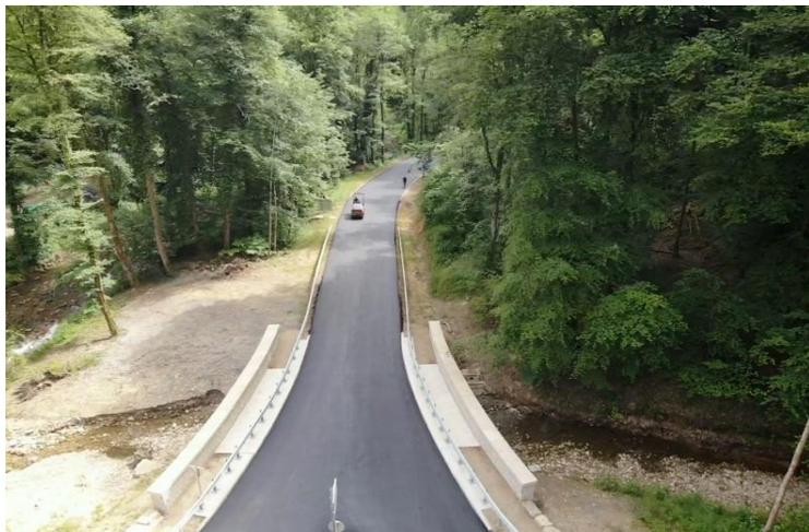
Les travaux ont commencé avec l'enlèvement du pont provisoire, la destruction des fondations de l'OA355 et de l'OA359 ainsi que de la mise en place des accès provisoires. Le réaménagement du CR118, comprenant les terrassements, la construction des rigoles et la mise en place des glissières ainsi que de la couche de liaison a ensuite été réalisé. S'agissant de la réhabilitation de l'OA4472, l'ancienne structure
