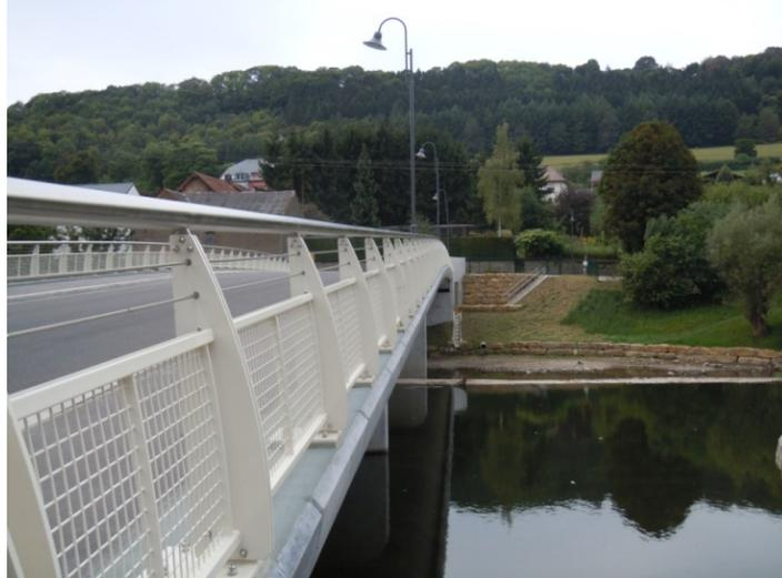
Les appuis du tablier présentent également des formes architecturées. Les culées sont en béton armé structuré. La courbure des murs en retour prolongeant le garde-corps invite
