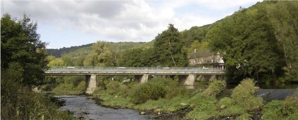
Le nouvel ouvrage devait pouvoir répondre aux contraintes suivantes : la réduction du nombre d'appuis dans la Sûre et le canal du moulin, l'augmentation de la hauteur libre sous l'ouvrage, l'adaptation à la configuration urbaine actuelle et permettre le maintien de l'ouvrage existant pendant les travaux.
