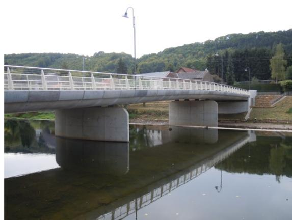
La construction du premier pont de Moestroff remonte à 1873. Il s'agissait d'un pont en maçonnerie de cinq travées en arc surbaissé, d'une portée totale de 64 mètres. Ce pont a été détruit durant la seconde guerre mondiale. Les quatre piles et les deux culées préservées, avaient alors été renforcées pour supporter un
