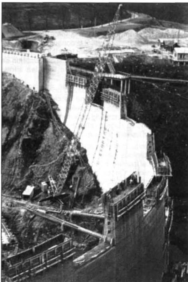
Photo 1: Bétonnage de la voûte.
