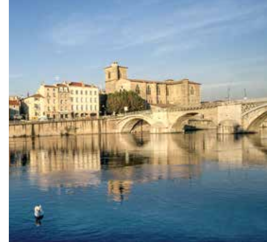
Pont-Vieux, Romans-sur-Isère (© Ville de Romans-sur-Isère)
