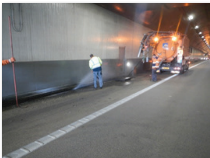
Nettoyage de caniveau
