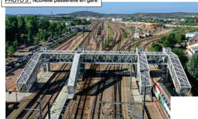
PHOTO 3 : Nouvelle passerelle en gare
