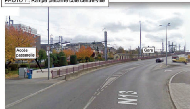
PHOTO 1 : Rampe piétonne côté centre-ville
