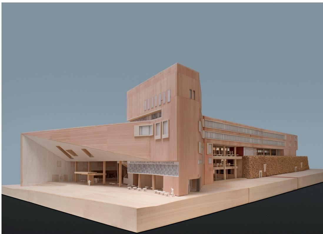
Des références régionales et propres au site ont été prises en compte et thématiques dans les couleurs et les matériaux des façades. Le soubassement du bâtiment est par exemple réalisé en gabions en utilisant les matériaux en provenance des pierres concassées issues des travaux de fouille dans la roche.
